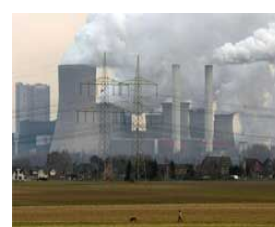
エネルギープラント
